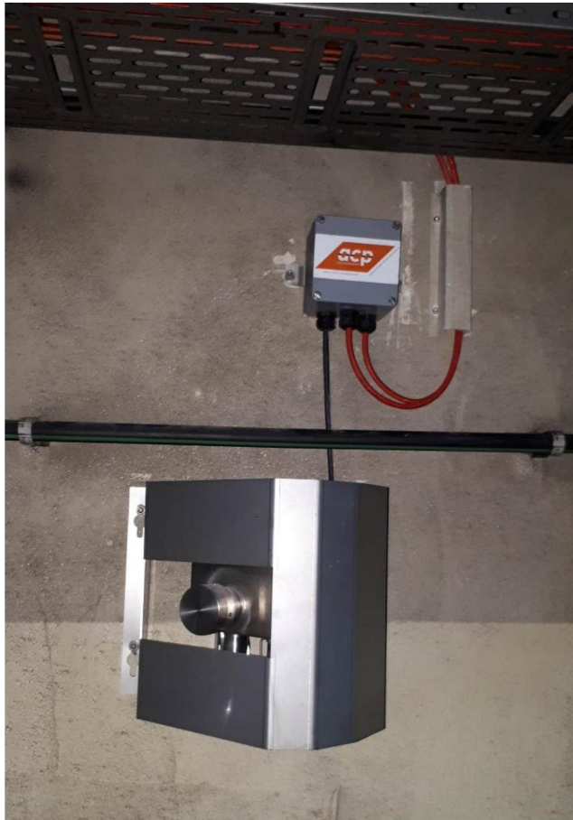
ACP Flowsic Messkopf mit Bürstenschutz
