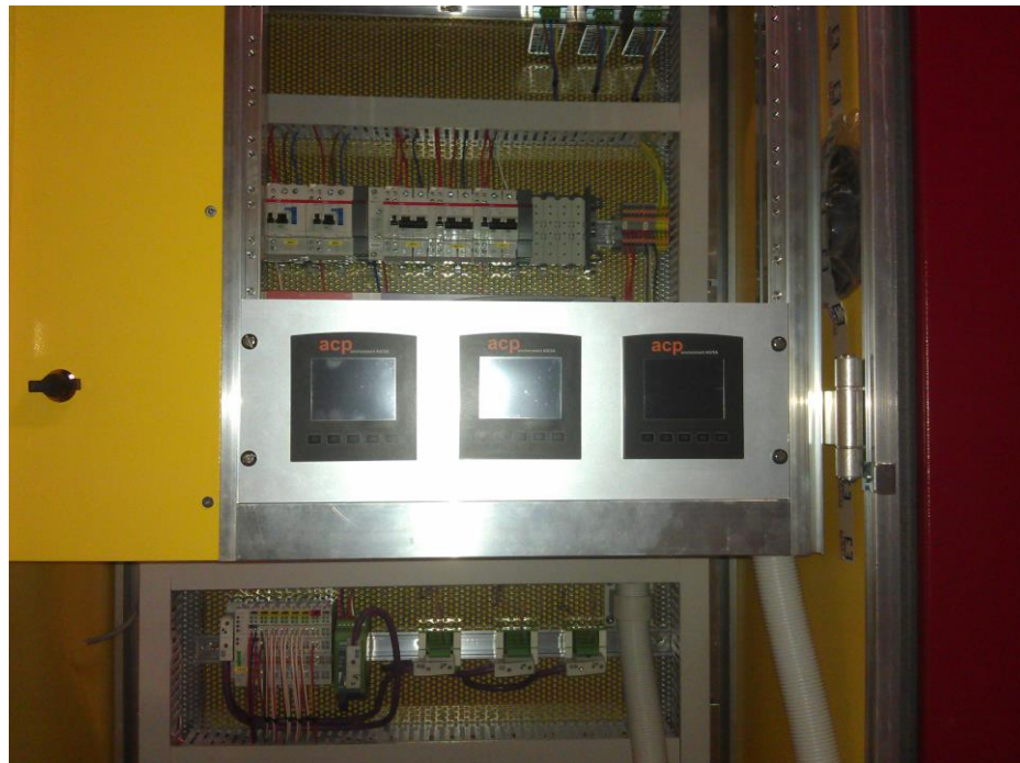
Montagebeispiel Frontrahmen-Einbau
